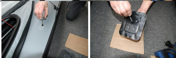
Bringen Sie die Seilbeschlagsplatte in der Nähe des Cockpits so an, dass Sie vom Sitz aus (bei Mehrsitzern vom vorderen Sitz aus) darauf Zugriff haben. Sie müssen die Platte also erreichen können, um das Segel zu bedienen. Ferner darf die Platte nicht an einer Stelle platziert werden, wo die Haut später gefaltet wird!
